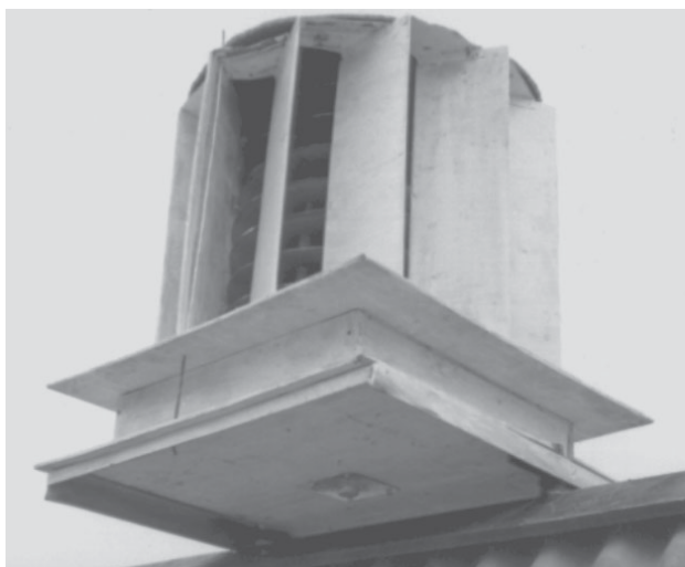
Рис. 1. Ветроустановка с фрикционным ротором
